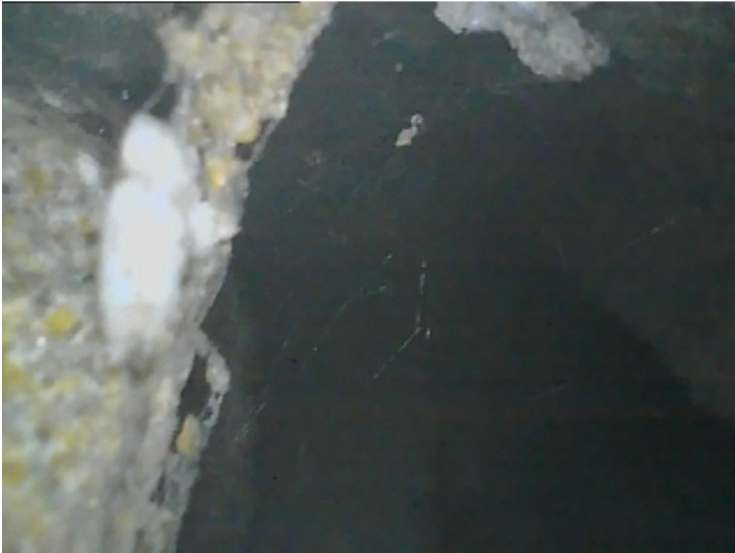
Abbildung 17: Blick in einen Hohlraum mit Spinnweben - keine Hinweise auf ein Habitat
