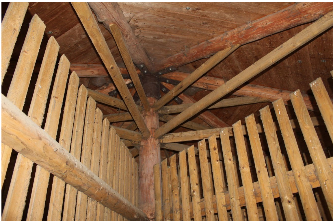
Abbildung 8: Blick in die Holzkonstruktion des Fahrradpavillons
